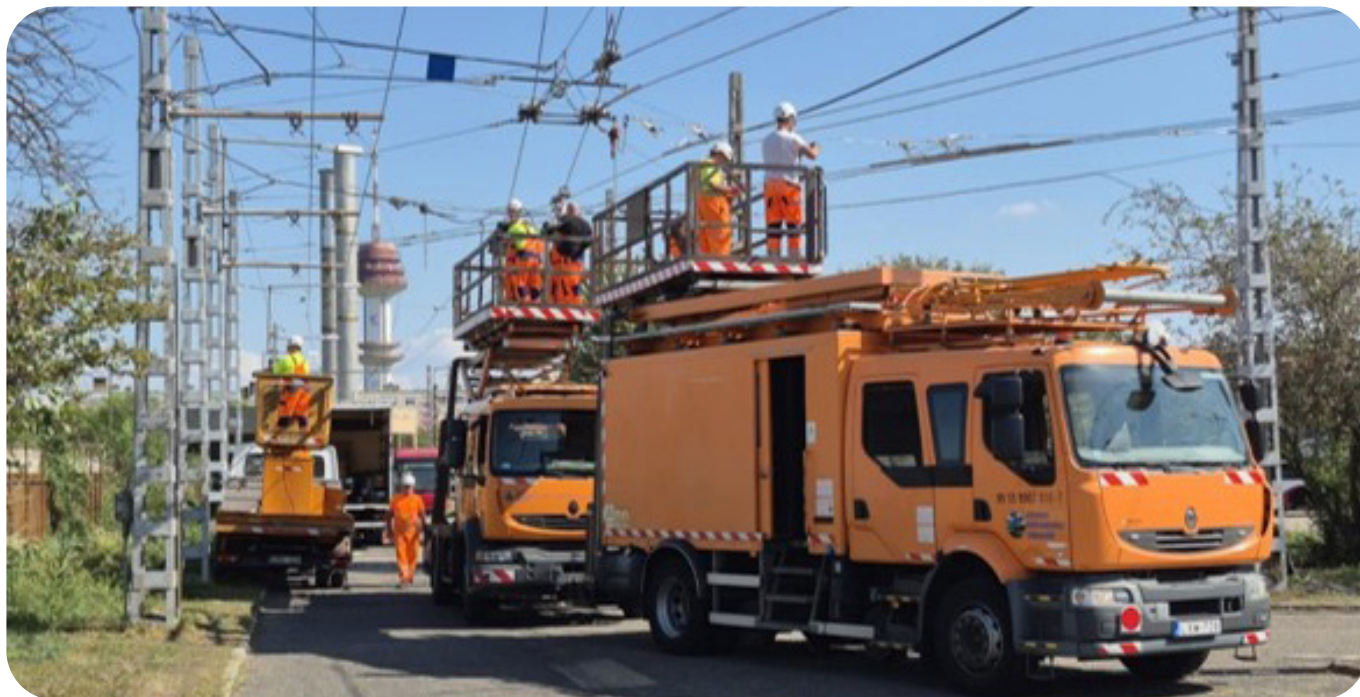
Obrázok 24: Inštalácia trolejbusovej výhybky tímom údržby SZKT.
