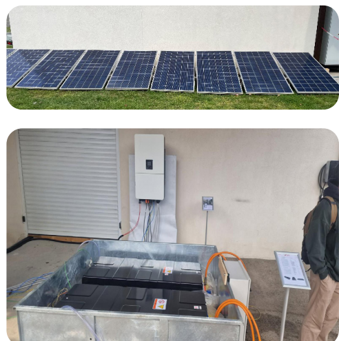
Rysunek 27: Kluczowe komponenty systemu BESS: panele PV, przekształtnik i pakiet baterii z drugiego życia.
