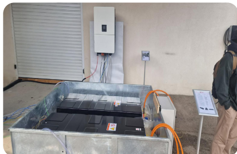
Figura 27: Componenti chiave del sistema BESS: pannelli FV, inverter e pacco batterie di seconda vita.
