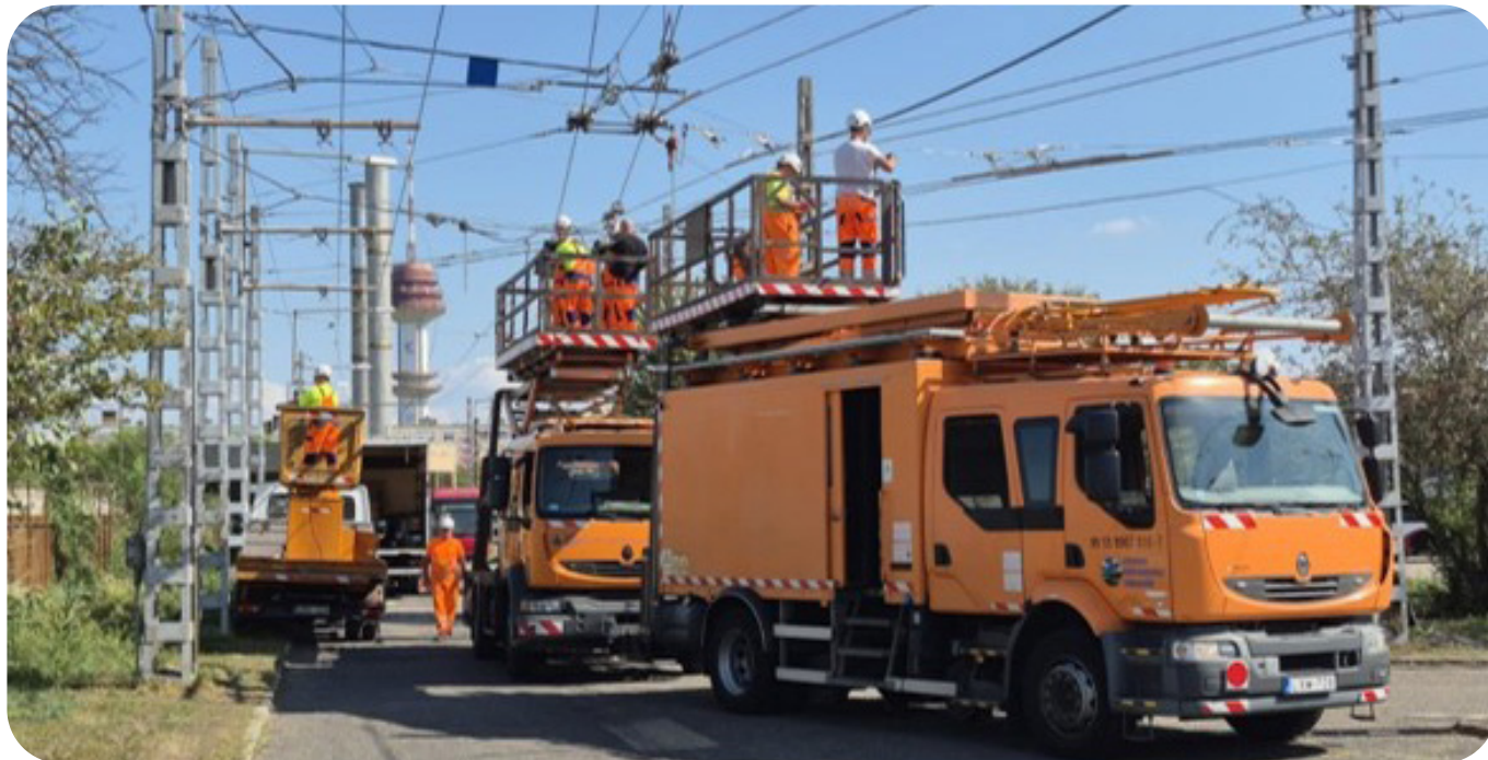
Slika 24: Ugradnja trolejbusne skretnice od strane održavateljskog tima SZKT-a.
