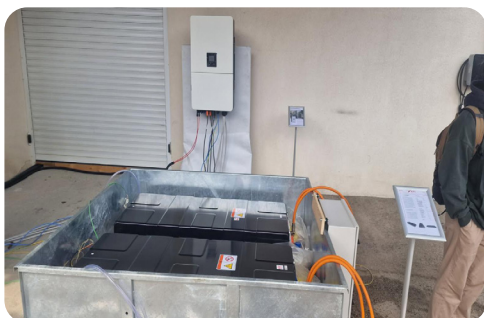
Slika 27: Ključne komponente sustava BESS: PV paneli, pretvarač i baterijski paket u drugom životnom ciklusu.
