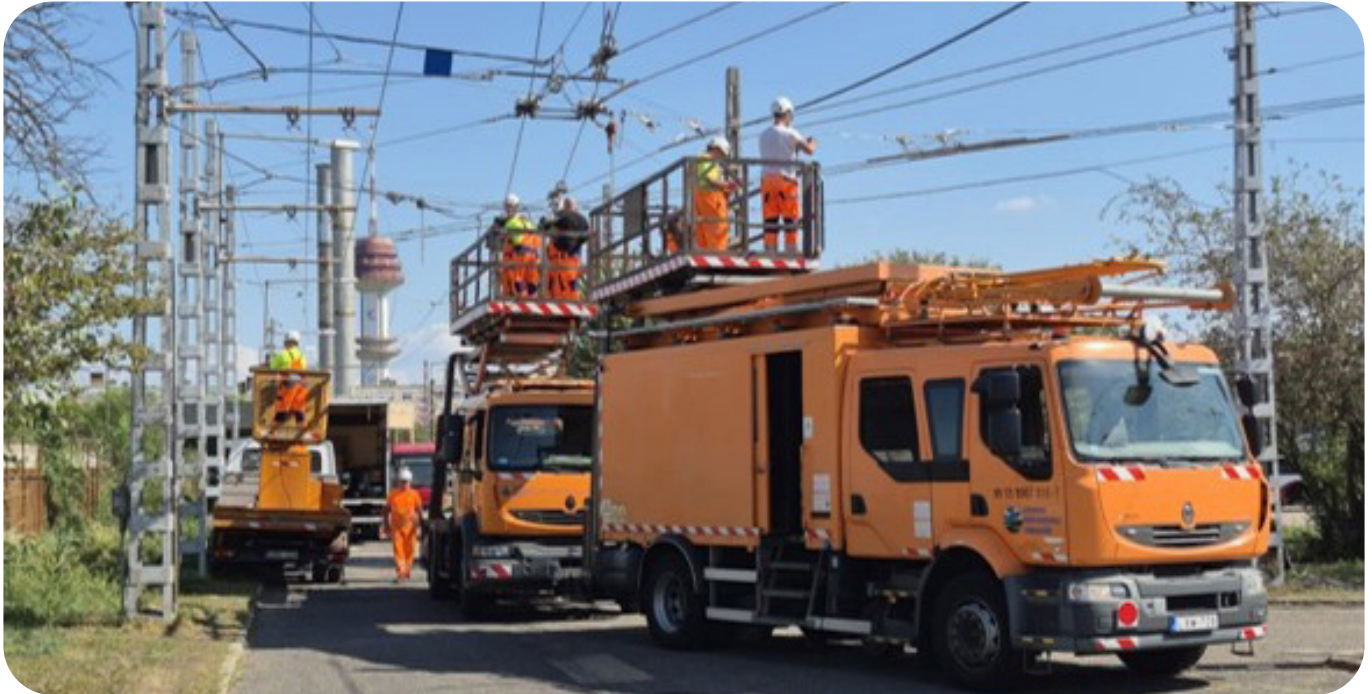
Abbildung 24: Einbau einer Trolleybusweiche durch das Instandhaltungsteam von SZKT.
