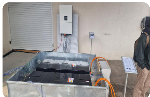
Obrázek 27: Klíčové komponenty systému BESS: FV panely, střídač a bateriový blok s druhým životním cyklem.
