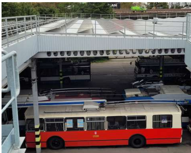
Obrázok 13. Fotovoltaická elektrárňa napájajúca trolejbusy v depu. Zdroj: CE4CE
