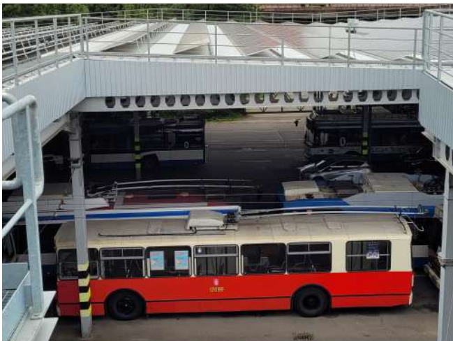
Abbildung 13. Photovoltaikanlage zur Stromversorgung der Oberleitungsbusse von Gdynia im Depot. Bildnachweis: CE4CE
