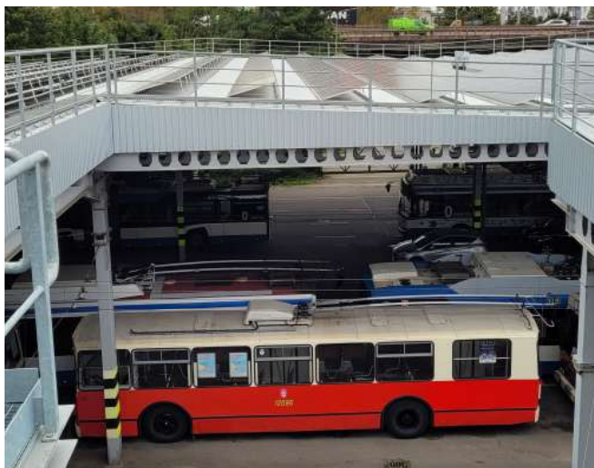
Obrázek 13. Fotovoltaická elektrárna napájející trolejbusy v Gdyni v depu. Zdroj: CE4CE
