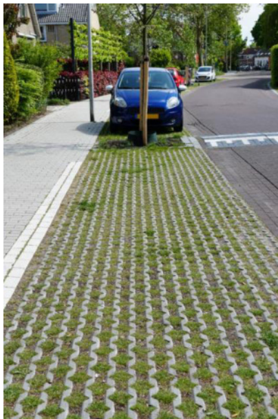
Abbildung 8: Beispiel für Versickerungsfähige Parkflächen (© vsr-gewaesserschutz.de)
