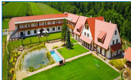
Foto 1 - celkový pohled na budovu
