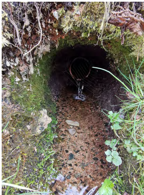
Abbildung 3 Tier2_Oberweissenbach_03.jpg - Drainageleitungen in der unteren Teilfläche; dokumentierter Eingriff in das Wasserregime
