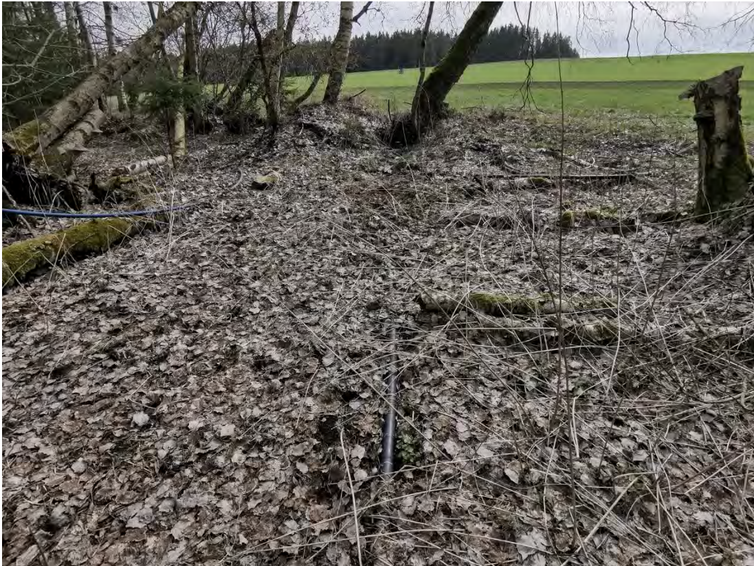
Abbildung 17 Tier2_MuehlbacherWaldung_07.jpg - Rohrleitungen am Oberhang leiten das anstehende Wasser gezielt um den Moorkörper zu den mittleren Teichen ab
