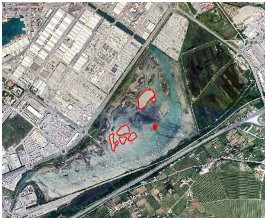
Slika 10: NRŠZ pred (2012, levo) in po (2023, desno) geomorfoloških spremembah v korist gnezditveni površini in Natura 2000 habitatom.
