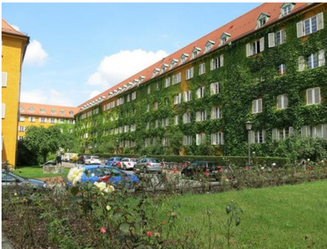
Irodaház futtatott homlokzata, München.
