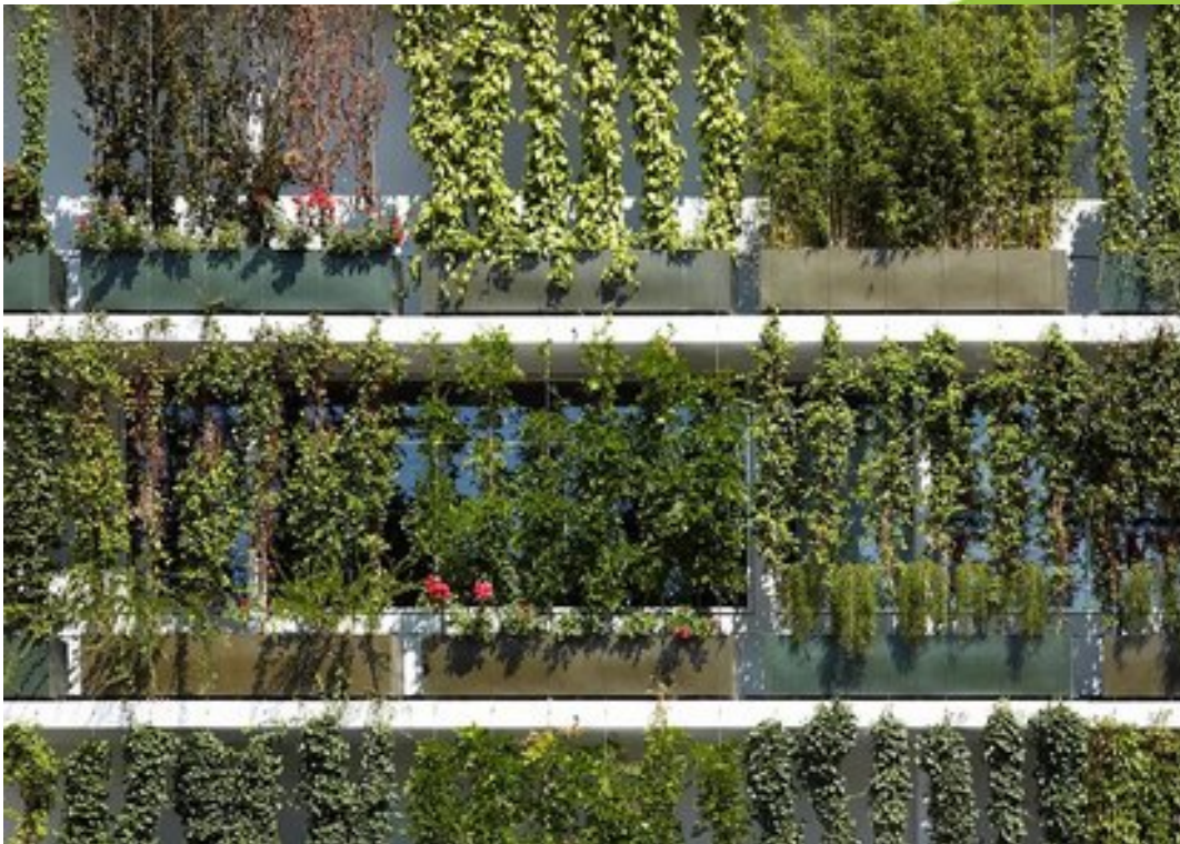
Sodronyos futtatórendszerrel árnyékolt épület
